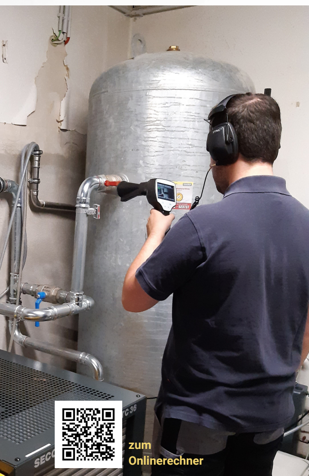
Bild: Unsere Fachmonteure orten, dokumentieren und beheben Druckluftleckagen.
